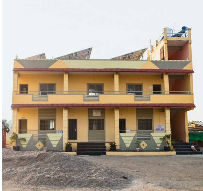
Panneaux solaires récemment installés à l'orphelinat Balgram (Crédits photo : REAF II)
